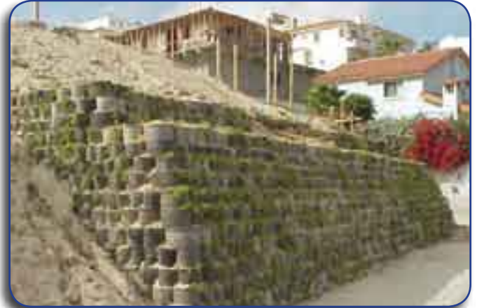
Whole tire wall used to impede soil erosion Photo courtesy of La Comisión Estatal de Servicios Públicos de Tecate
